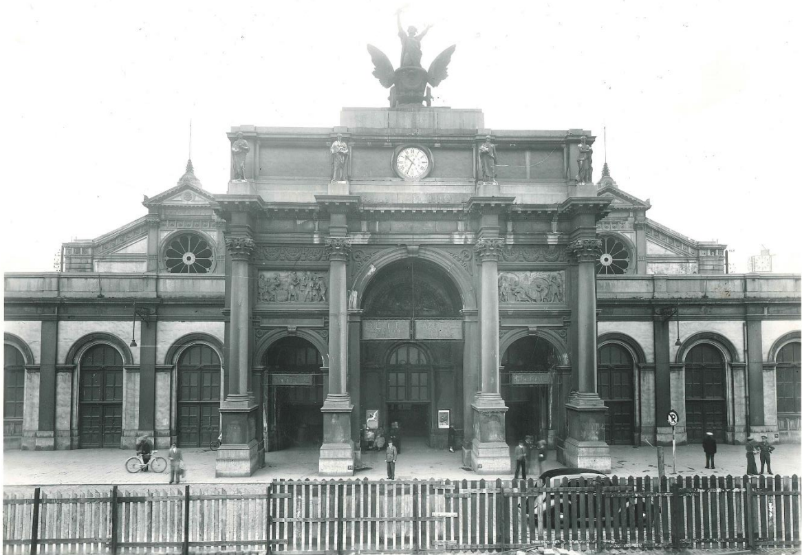
Ill. 2 Portique d'entrée de l'ancienne gare du Midi. (©KIK-IRPA, cliché B100878).
