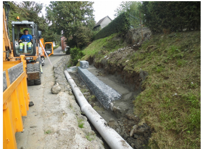
Travaux rue du Palais - 2016
