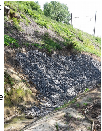
Consolidation des berges du Ri par Infrabel - 2017
